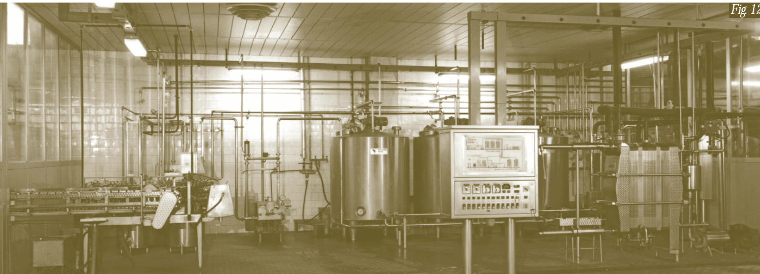
Fig 12 Impianto di sgusciatura e pastorizzazione uova anni '80.
